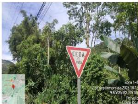
Fotografía No.4: Demarcación reglamentaria, Puente Cacao.
