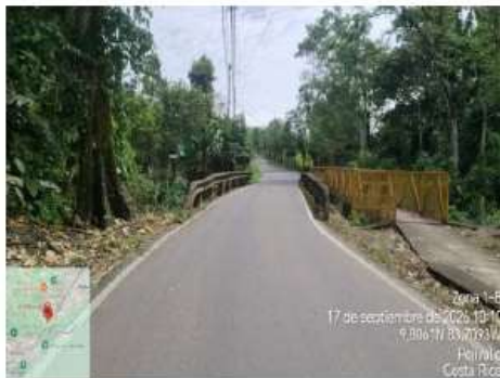
Fotografía No.1: Ruta Nacional No.408, vista general, Puente Cacao.
