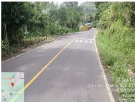
Fotografía No.2: Demarcación reglamentaria, Puente Cacao.
