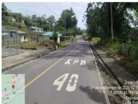
Fotografía No.3: Demarcación reglamentaria, Puente Cacao.
