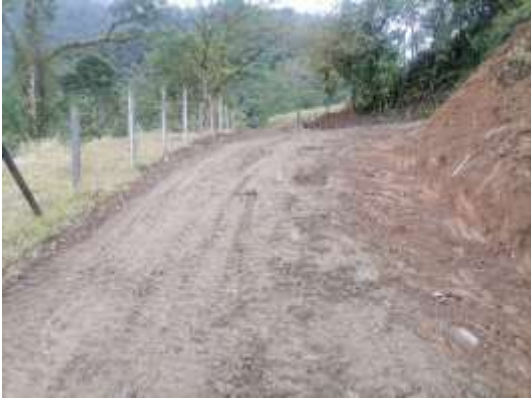
1 e. Limpieza mecanizada de la superficie de ruedo en el camino La Esperanza de Pejivalle 2 con maquinaria municipal en el año 2023. Sustitución de un paso de alcantarilla a la 3 entrada del puente hacia Maquina Vieja.
