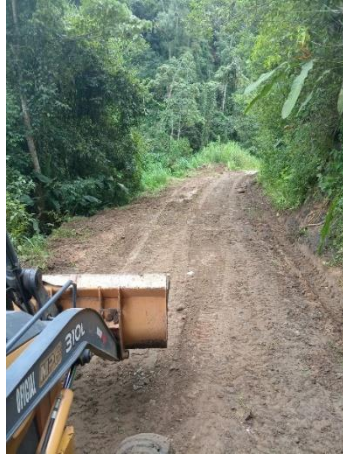
1 17. Limpieza mecanizada y estabilización de taludes en el camino Bajo Cazuela.
