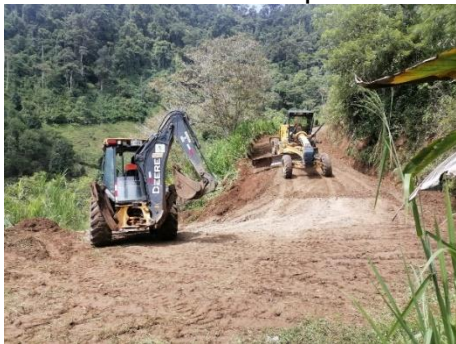
2 11. Rehabilitación de la superficie de ruedo Sector Las Zetas, camino La 20.
