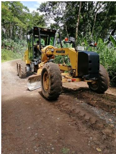
2 11. Rehabilitación de la superficie de ruedo Sector Las Zetas, camino La 20.
