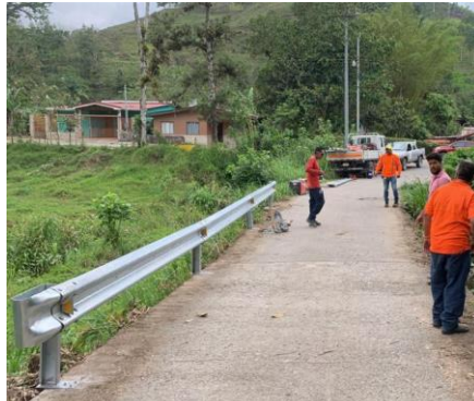
Puente sobre Rio Gato (Flex beam)
