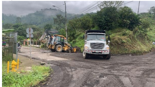
5 20. Colocación de material granular, sector Las Américas, en El Humo de 6 Pejibaye
