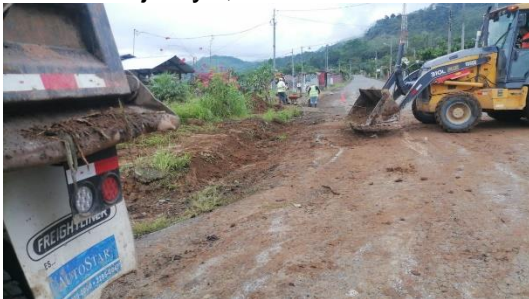
5 20. Colocación de material granular, sector Las Américas, en El Humo de 6 Pejibaye
