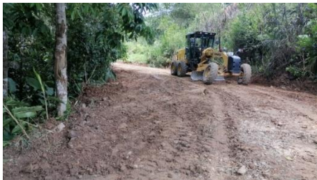
12. Limpieza mecanizada y estabilización de taludes en el camino Bajo Cazuela.
