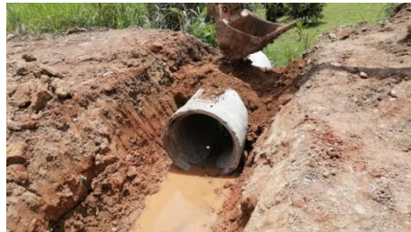
11. Limpieza mecanizada y sustitución de un paso de alcantarilla en el camino Palo Negro de Pejibaye
