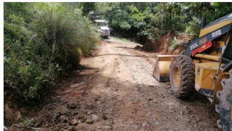
12. Limpieza mecanizada y estabilización de taludes en el camino Bajo Cazuela.
