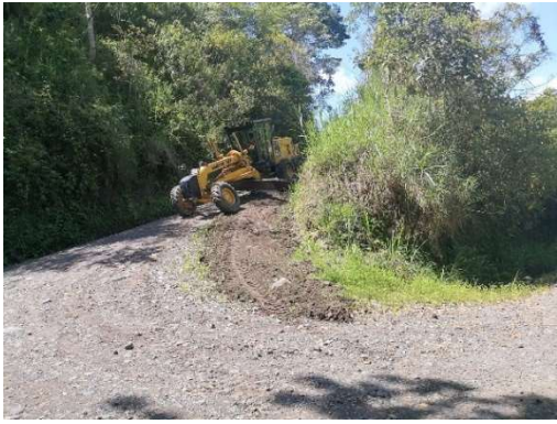
1 c. Limpieza mecanizada de cunetas en tierra, en el camino San Martín.
