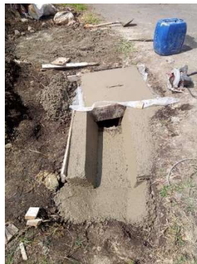
1 12-Construcción de caja de registro en el sector Los Mora, en La Victoria de 2 Juan Viñas.
