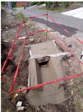
1 12-Construcción de caja de registro en el sector Los Mora, en La Victoria de 2 Juan Viñas.
