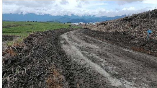
1 c. Limpieza mecanizada de cunetas en tierra, en el camino San Martín.
