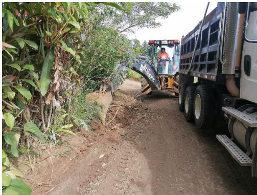
1 4. Sustitución de un paso de alcantarilla en el camino San Francisco, El Humo 2 de Pejibaye 3
