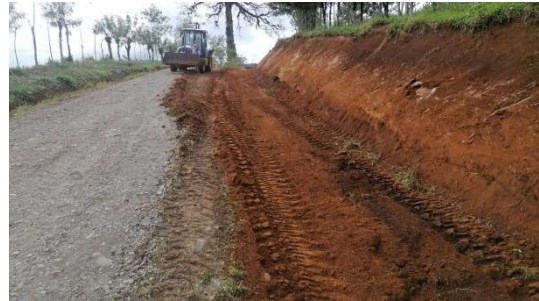
1 13. Limpieza manual del derecho de vía en el camino El Desecho de Juan Viñas.
