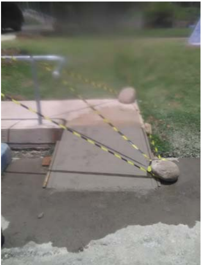
Sustitución Tubería Sanitaria Ubicación: El INVU, Juan Viñas
