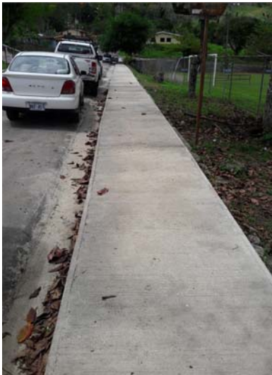
Actividades Realizadas 1- Se realiza la sustitución de 60 metros lineales de tubería sanitaria en el sector El INVU de Juan Viñas, esto debido a un daño en la tubería de alcarraza que disponía las aguas del sector. 2- Se construyen además dos cajas de registro para brindar mantenimiento a la tubería colocada.
